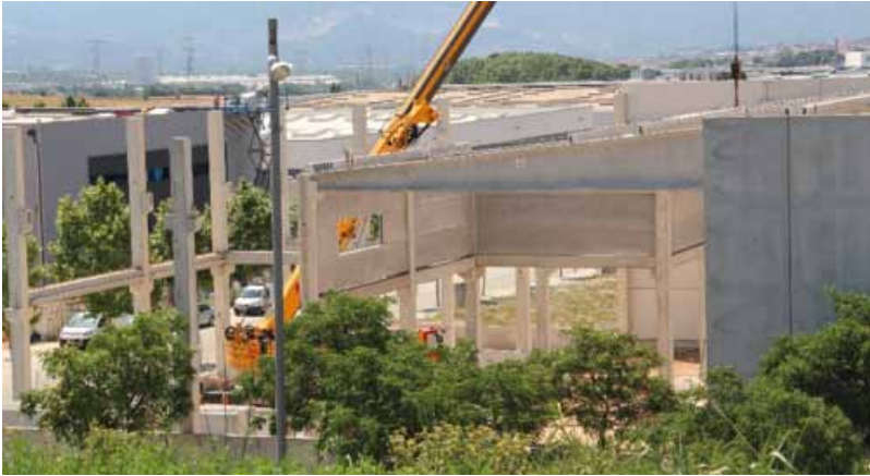
Fig. 24. Tècniques i sistemes constructius per a la construcció d'una nau industrial. Imatge de Steven González. Polinyà. (2018).
